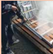
■仮設資材の洗浄
