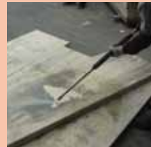
■型枠合板の洗浄
