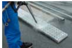
仮設資材の洗浄
