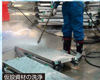
仮設資材の洗浄
