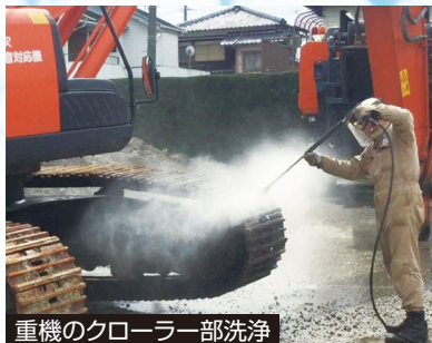
重機のクローラー一部洗浄
